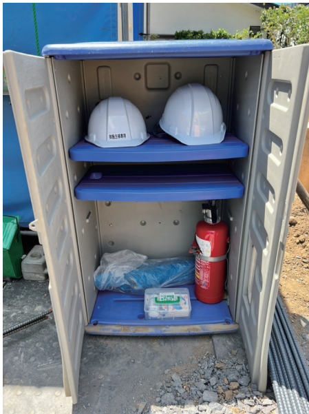
◎ 保安ボックス設置例
